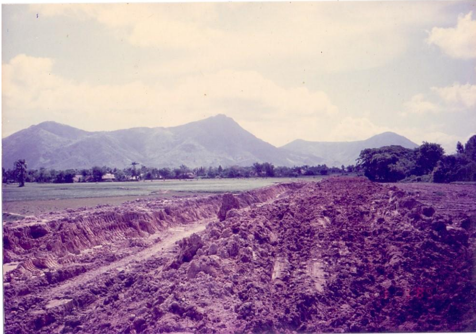
Ảnh: Đang thi công đường nước nối Trạm bơm Châu Kim Sông (Châu Lăng)
